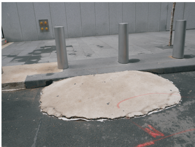
Ryc. 10.2. Na obejściach należy umożliwić zjazd z chodnika poprzez wykonanie tymczasowych pochylni (autor: M. Wysocki).
