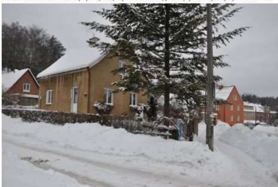
Fot. 3. Widok na obszar opracowania z obrębu skrzyżowania ulic Okrężnej i Księżycowej
